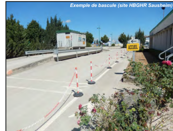
1/ Pesée du camion et premier contrôle olfactif et visuel au niveau de la bascule
